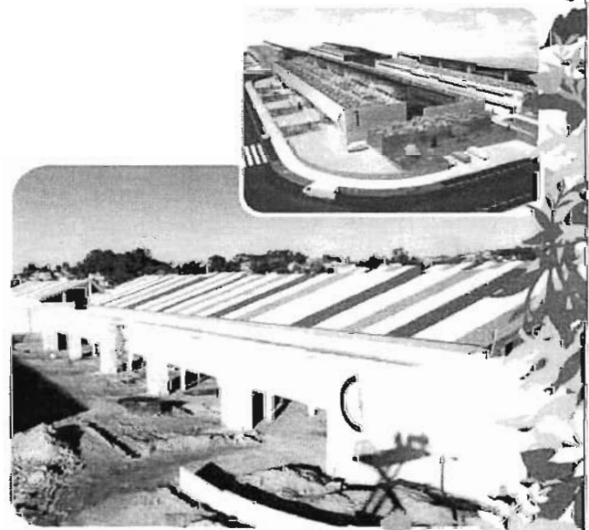
Remate das obras febreiro 2011
